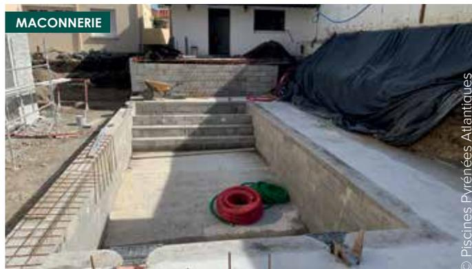
**Sur les pourtours de la dalle de fond, un drain périphérique de Ø 60 cm draine l'eau du terrain avant d'être évacuée par un puits de décompression.**
