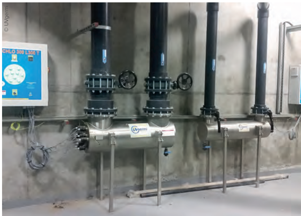
La mise en place d'une technologie UV maîtrisée multi-lampes permet de répartir uniformément la dose UV dans l'appareil et de garantir un traitement homogène sans surdosage UV-C (type de rayonnement UV).
