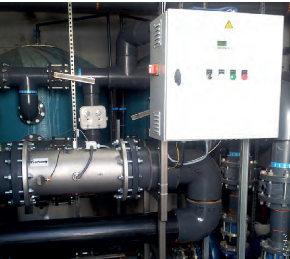
Pour des débits allant jusqu'à 500 m 3 /h, la moyenne pression utilise une seule lampe. L'appareil est installé, horizontalement ou verticalement, après les filtres, sur la totalité du débit de filtration.
